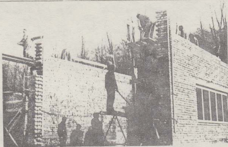
Az Univerzális üzem és a TMK épülete közötti szabad területen épül az új szerelőcsarnok. (Fotó: Berkó)
